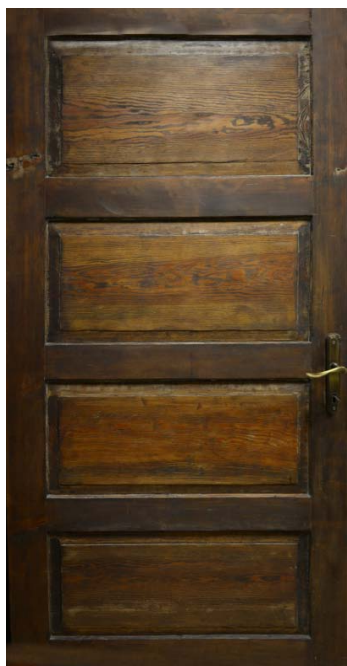
ISTNIEJĄCE DRZWI Z LEŚNICZÓWKI
